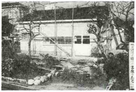
▲建築中の北神小規模作業所
