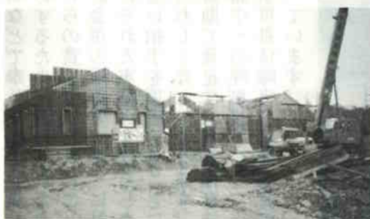
建設中のワークホーム「明友」
